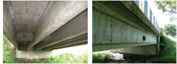
Fig. 1 Szczercowska Wieś bridge before reconstruction.
