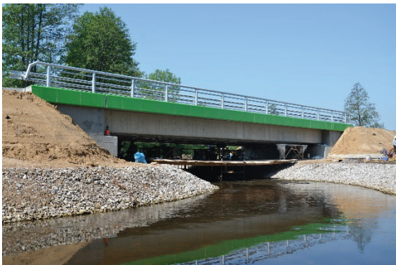
Fig. 14 Szczercowska Wieś bridge after reconstruction.
