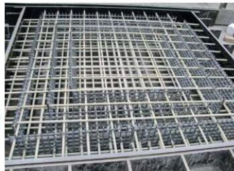
KOMPOZITNÍ VÝTZUŽ PŘED BETONÁŽÍ
