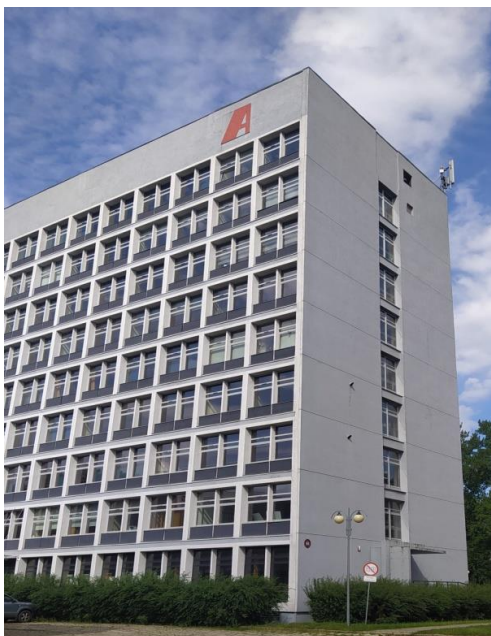
Rys. 4. Badany obiekt od strony południowej
