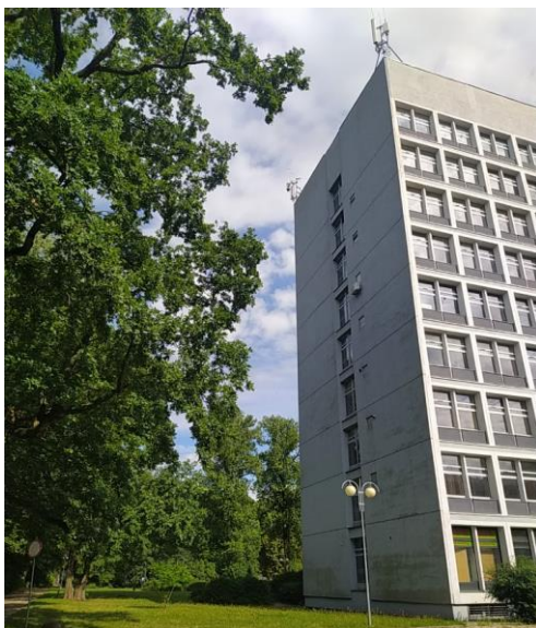
Rys. 5. Badany obiekt od strony północnej
